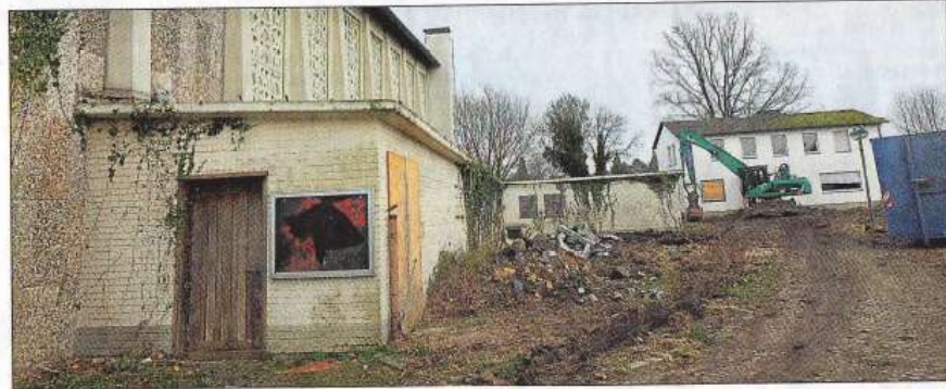
Die Anbauten auf der westlichen Seite werden abgerissen. Von hier aus werden die drei Kindergartengruppen künftig erschlossen.
