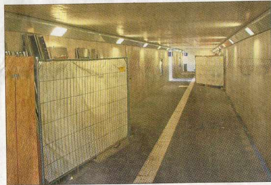
Noch immer eine Baustelle ist der Tunnel, durch den die Fahrgäste zu den Bahnleisen gelangen. Aufzüge sind noch nicht eingebaut.
