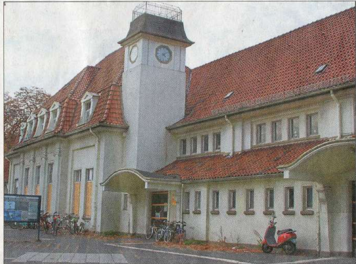
Im denkmalgeschützten alten Bahnhofsgebäude hat sich in den vergangenen knapp zwei Jahren noch nicht viel bewegt.
