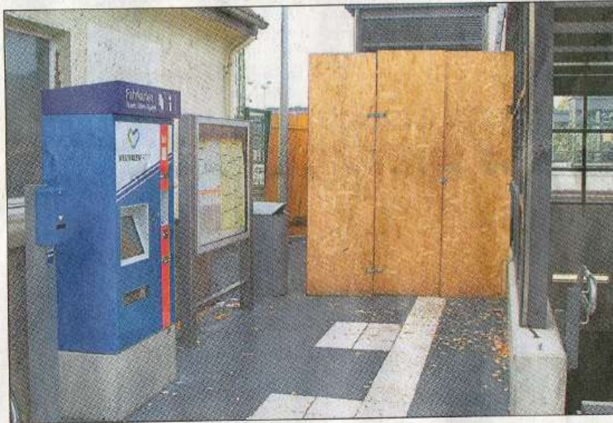
Eine Holzwand markiert die Stelle, an der künftig der Aufzug die Bahnreisenden hinunter in den Fußgängertunnel befördern soll.
