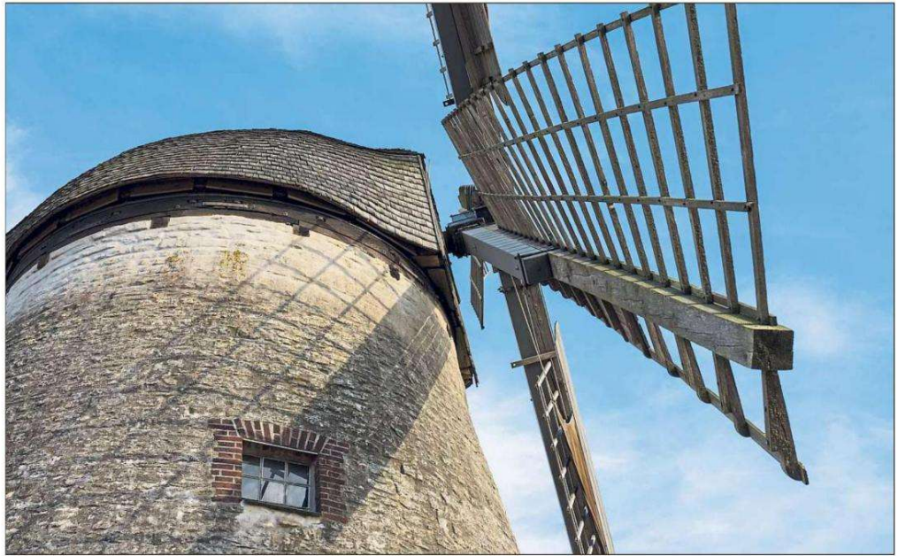
Seit 1853 steht die Mühle am Höxberg in Beckum. Seit 15 Jahren kümmert sich die „Mühlenrunde“ darum, dass das Denkmal immer gut in Schuss ist. Feiern kann das Team sein 15-jähriges Bestehen in diesem Jahr aufgrund der Corona-Krise allerdings nicht. Bilder: Biefang/Fernkorn
