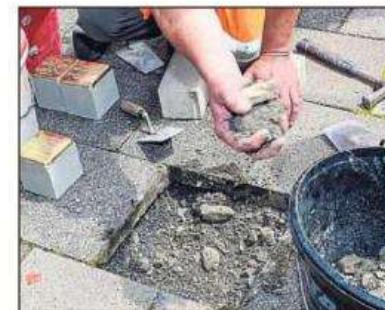
Die Gedenktafeln wurden an der Neubeckumer Straße in den Gehweg eingelassen.
