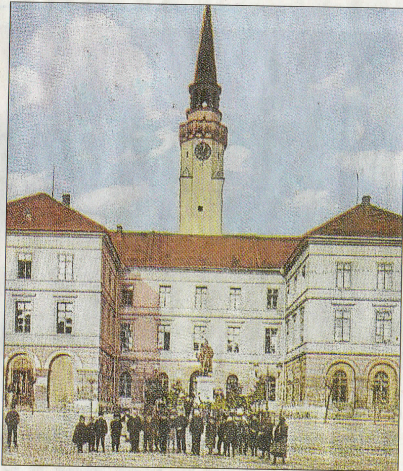
Einen 36 Meter hohen Turm wies der Rathausbau von 1840 im schlesischen Grottkau nahe Nicklasdorf auf.
